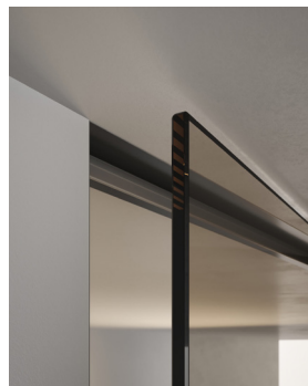
ZÁRUBEŇ S NADPRAŽÍM V PRŮBĚŽNÉM STROPU
